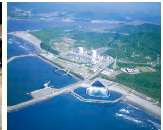
原子力発電所
