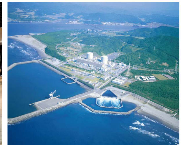
原子力発電所
