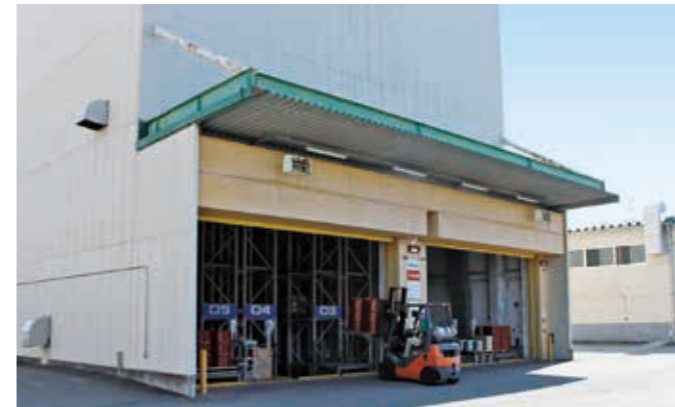
危険物自動倉庫
